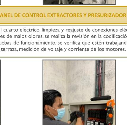
Cada 3 meses se realiza la limpieza y reajuste de conexiones a los paneles de distribución general, se realiza mediciones de voltajes, toma de lectura de corriente para evitar que exista breakers recalentados.
